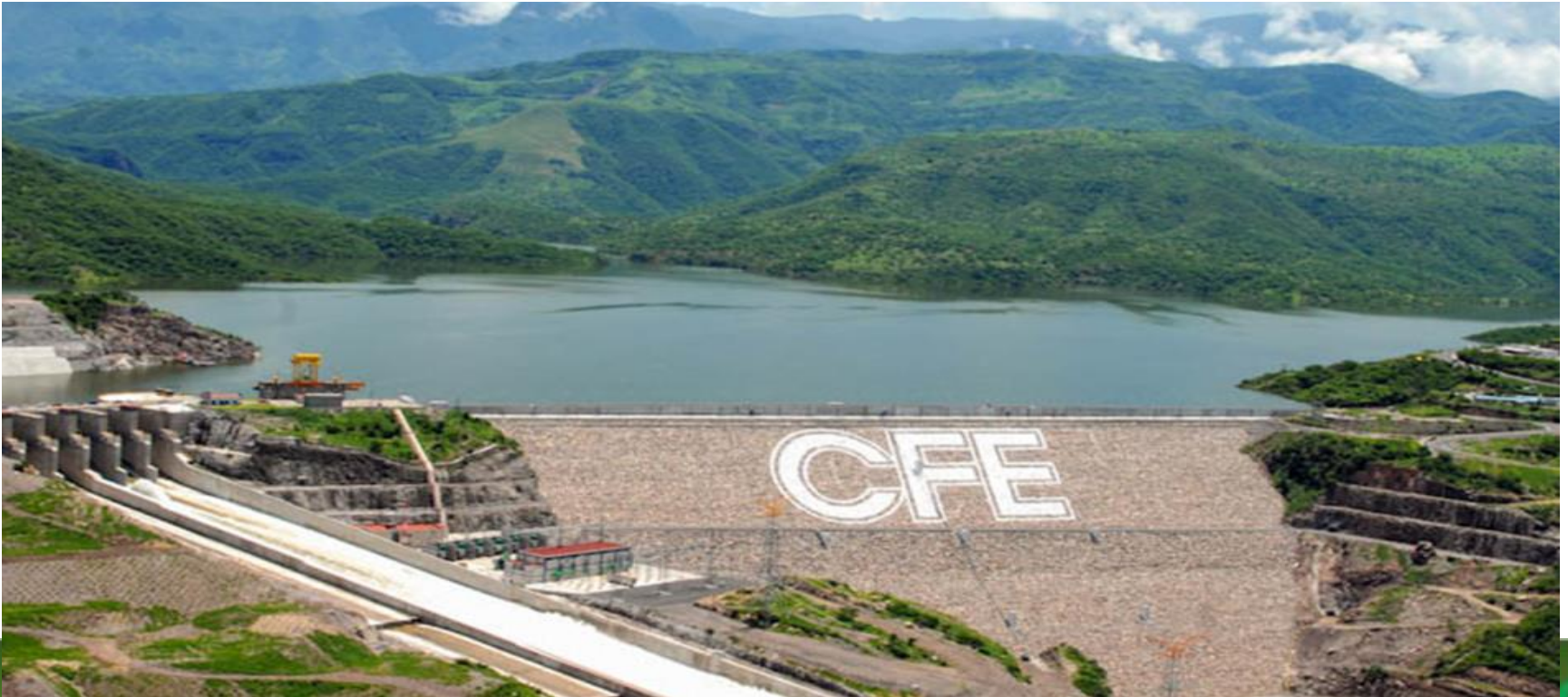
Presa el Cajón, Nayarit
