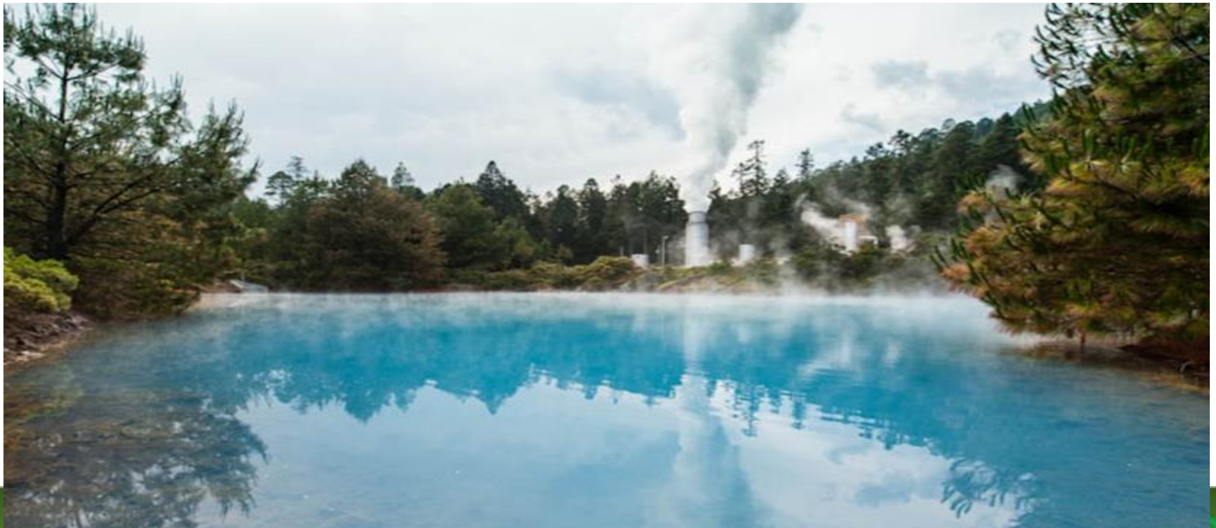
Campo Geotérmico Los Azufres, Michoacán
